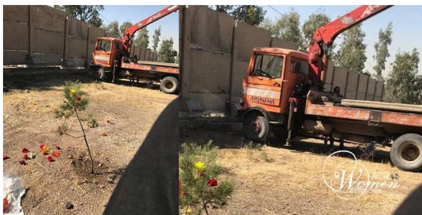
Construction de murs autour du cimetière de Khavaran
