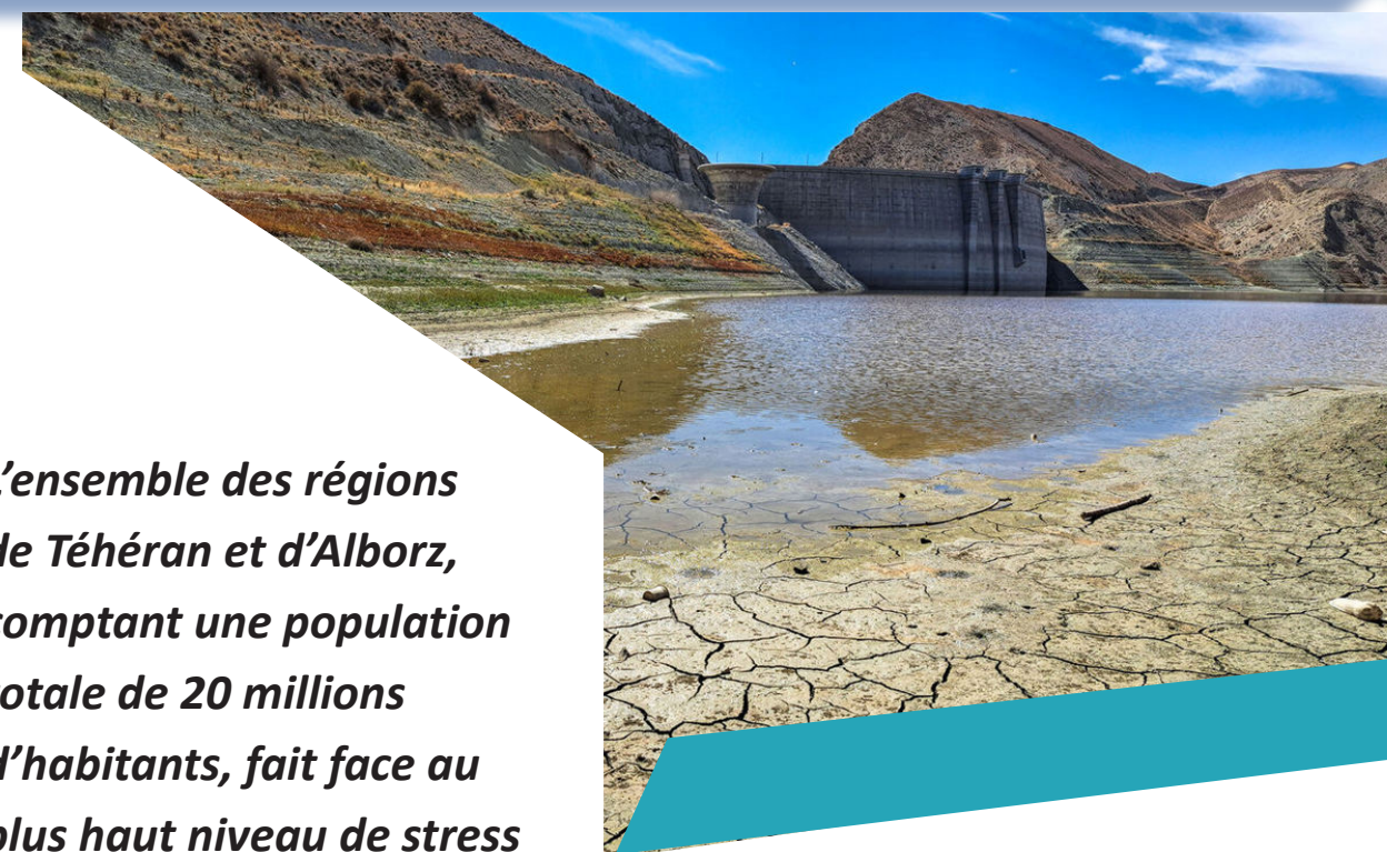
Barrage Amir-Kabir de Téhéran
